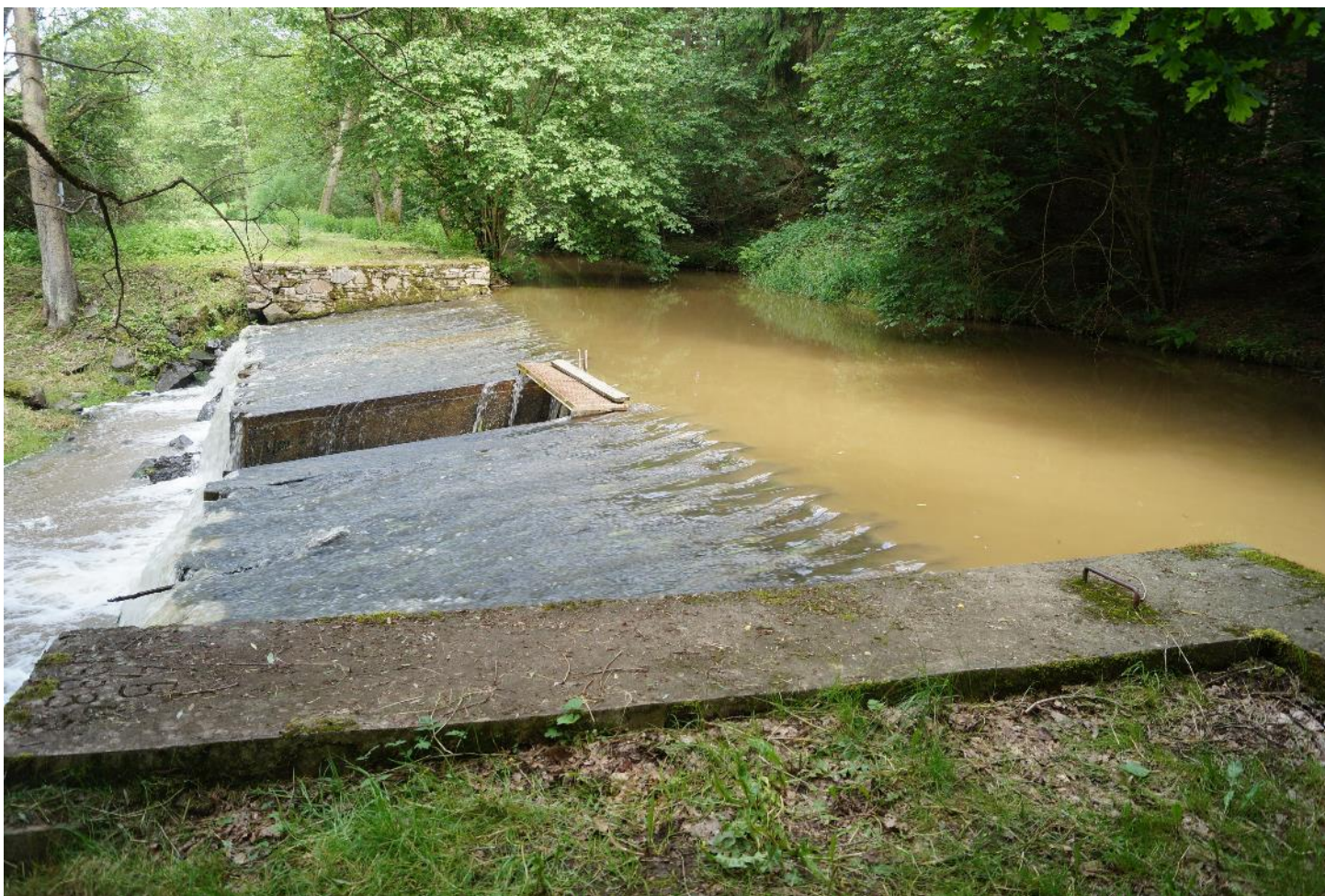
Přilehlý jez, trochu moc vody
