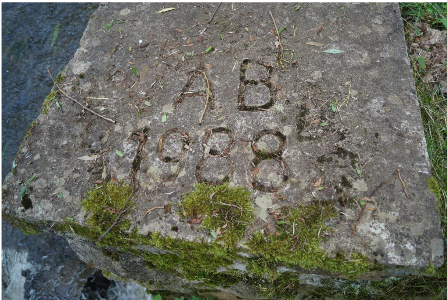
Armabeton postavil jez na jaře před naším prvním táborem
